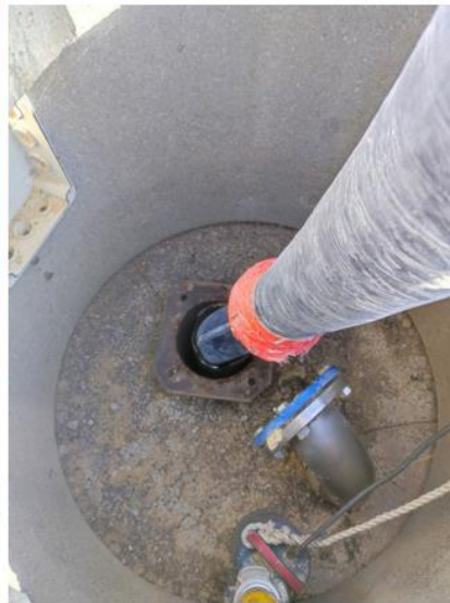
Abandon du forage de PINET Ornézon (pompe coincée) injection de coulis de ciment
