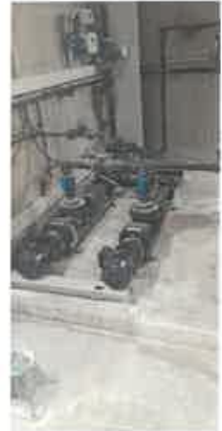
Fabrègues renouvellement de la pompe lait de chaux pour les boues 09/2021
