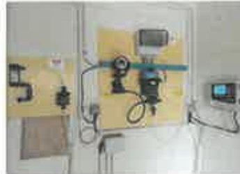
Montagnac forage renouvellement ensemble chloration avec détecteur fuite chlore 09/2021
