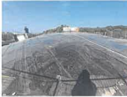
2023-06 Cournonterral Sainte Cécile avancée de l'étanchéité des toitures! Enlèvement des terres- nettoyage-isolation et étanchéité.
