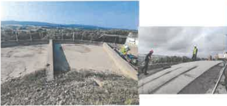
2023-06 Cournonterral Sainte Cécile avancée de l'étanchéité des toitures! Enlèvement des terres- nettoyage-isolation et étanchéité.
