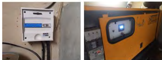
remise à neuf de l'armoire groupe électrogène
