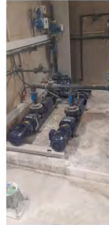
Montagnac forage renouvellement ensemble chloration avec detecteur fuite chlore 09/2021
