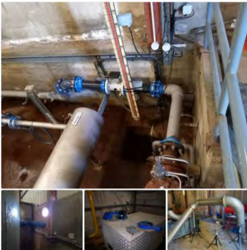
09/2021 début chantier Vias Farinette, bypass des 2 premières cuves
