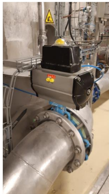
2022-10 Remise à neuf d'un actionneur pneumatique de régulation sur l'UTEP de Fabrègues .
