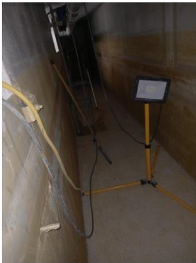
2022-01- étanchéité des bassins sur UTEP Fabrègues . séchage du canal avant application résine
