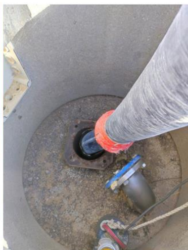
Abandon du forage de PINET Ormezon (pompe coincée) injection de coulis de ciment
