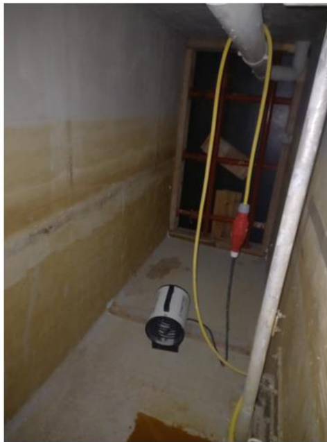
2022-01- étanchéité des bassins sur UTEP Fabrègues . séchage du canal avant application résine
