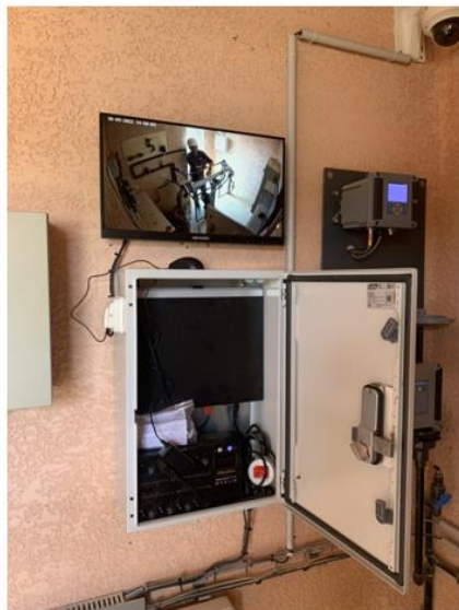
Clôture Florensac Caméra, contrôle d'accès et anti intrusion sur forage de Pinet
