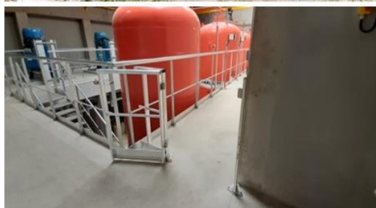
Gardes Corps Florensac Ensemble des puits P1-P12
