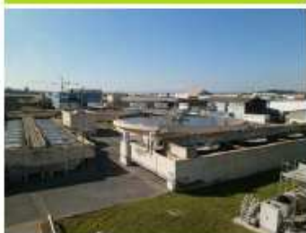
Station d'épuration des Eaux Blanches de Sète
