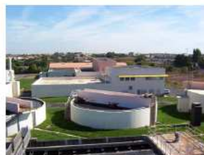
Station d'épuration d'Agde
